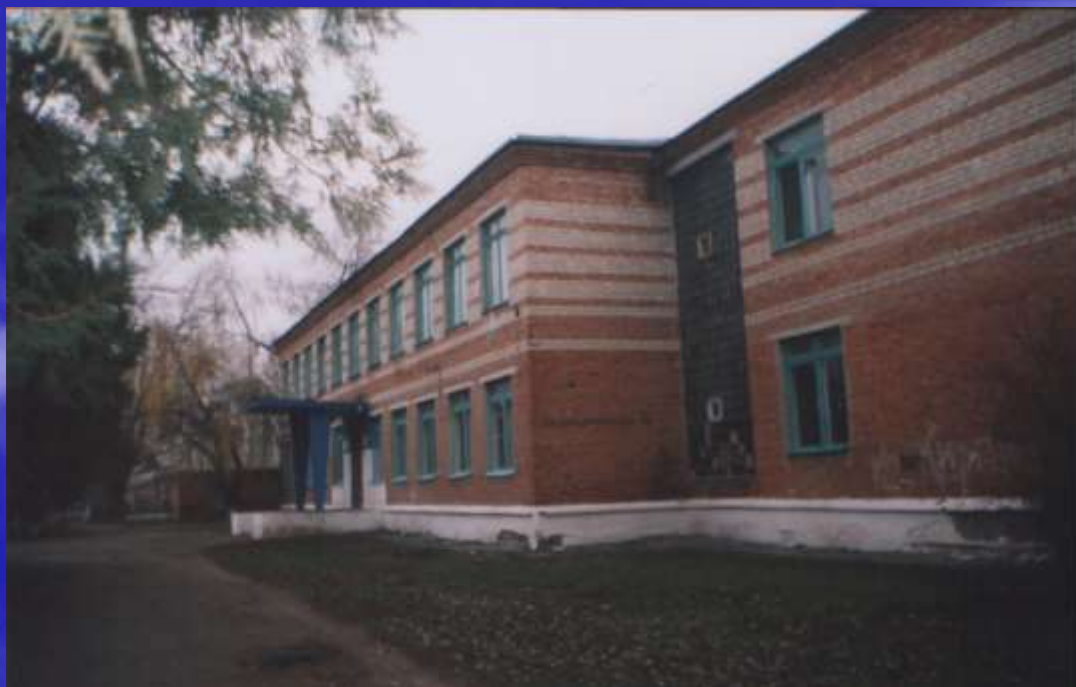
Новое здание СОШ №2
